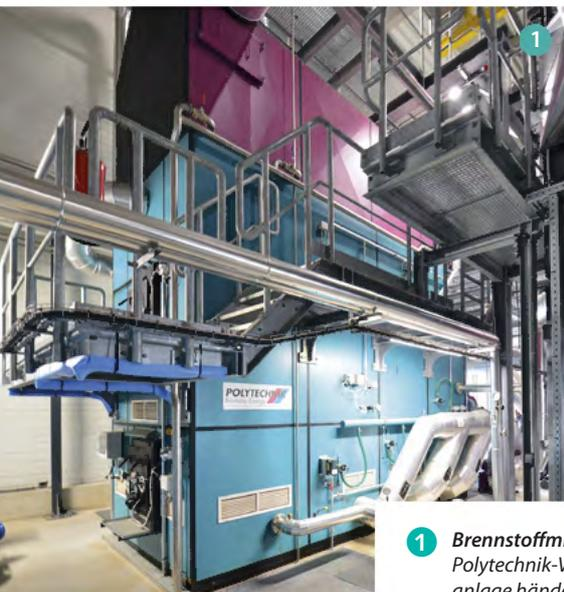
**1 Brennstoffmix:** Die 2,5 MW starke Polytechnik-Vorschubrostfeuerungsanlage händelt unterschiedliche Brennstoffe, sogar bei einem Wassergehalt von über 50 %
