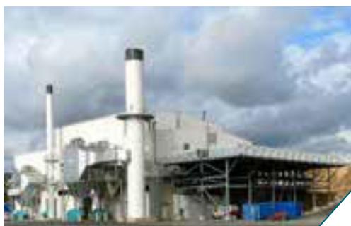
热电联产电厂和排放控制系统细节图像
