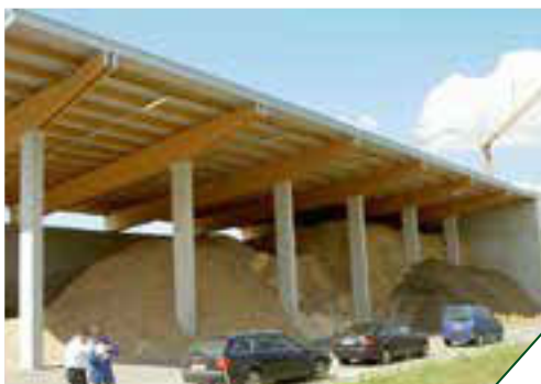
乳品厂覆盖着的燃料堆场细节图像
