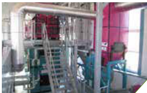
具有助燃空气预热器的2兆瓦热电厂
