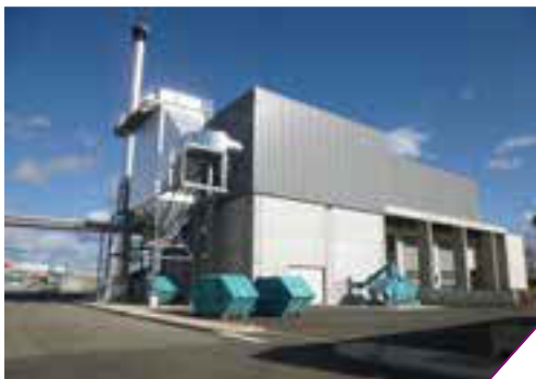
锅炉房有排放控制系统及燃料仓。
