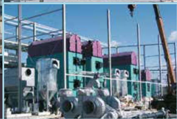
*Veličina postrojenja: 3 x 6.000 kW, 1 x 3.000 kW • Ložište: hidraulična pomicna rešetka
