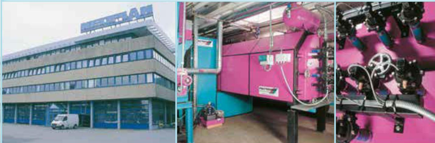
Ložište: hidraulična pomična rešetka • Gorivo: drvna sječka, palete, ambalaža • Pušteno u pogon: 1999. tj. 2001
