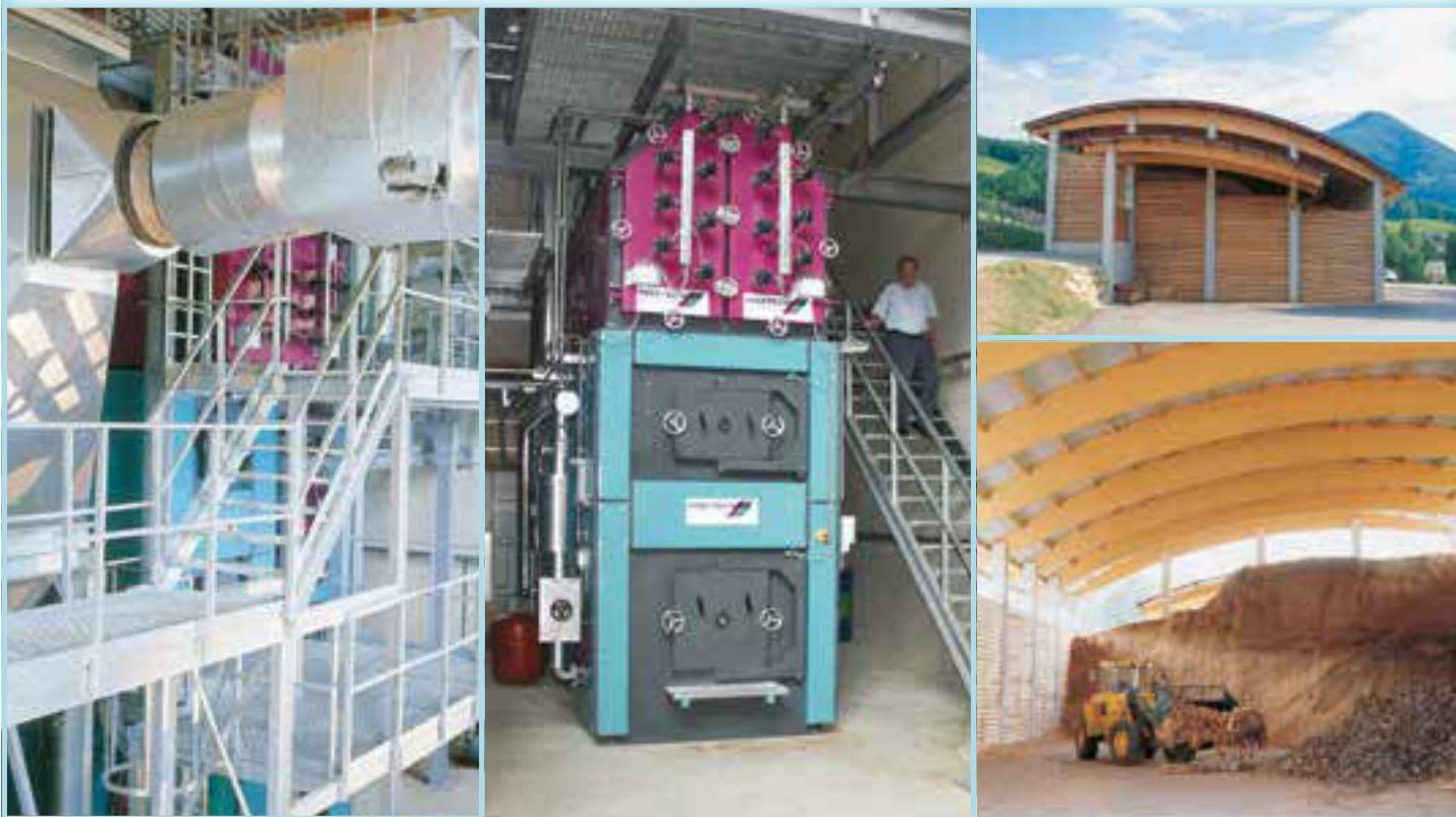
*Ložište: hidraulična pomična rešetka • Gorivo: šumski drvni otpad, kora • Pušteno u pogon: 2002*
