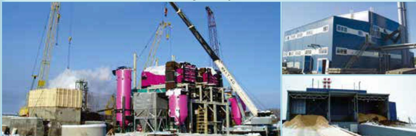
*Ložište: hidraulična pomična rešetka • Gorivo: drvna sječka iz pilane • Pušteno u pogon: 2008*
