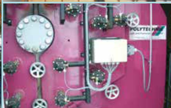
Para pod pritiskom 450° C, 32 bara, odvajanje topline za daljinsko grijanje • Ložište: hidraulična pomicna rešetka
