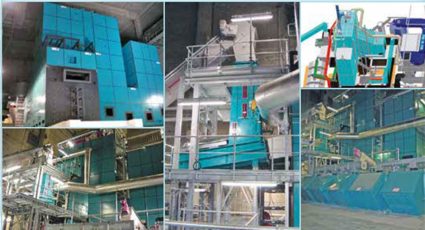
Para pod pritiskom  $430^{\circ} C$ , 60 bara, odvajanje topline za daljinsko grijanje • Ložište: hidraulična pomicna rešetka s odvodom dimnih plinova na sredini rešetke • Gorivo: ostaci iz sita iz proizvodnje komposta, kora, drvna sječka • Pušteno u pogon: 2011
