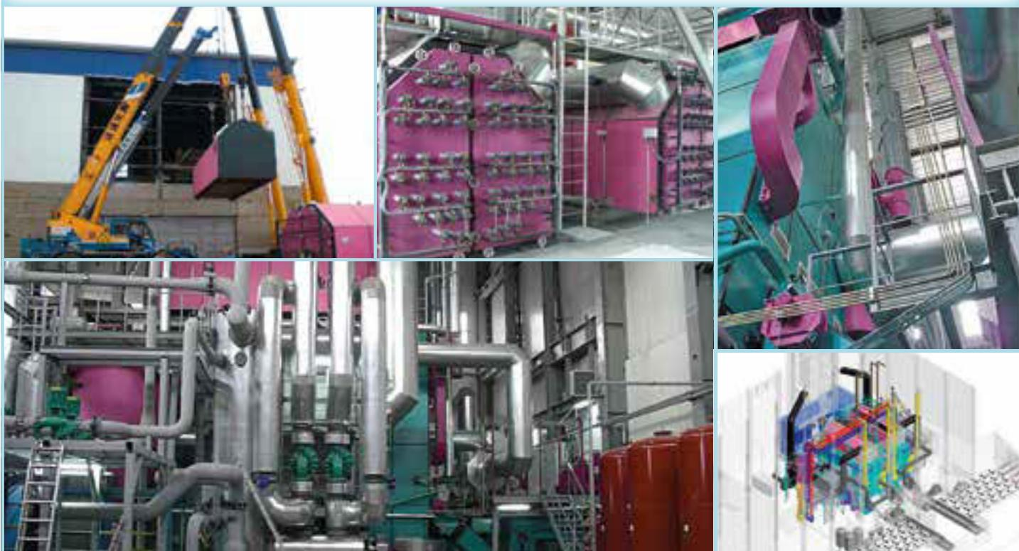
*Vruća voda (115 ° C), procesna toplina • Ložište: hidraulična pomična rešetka
