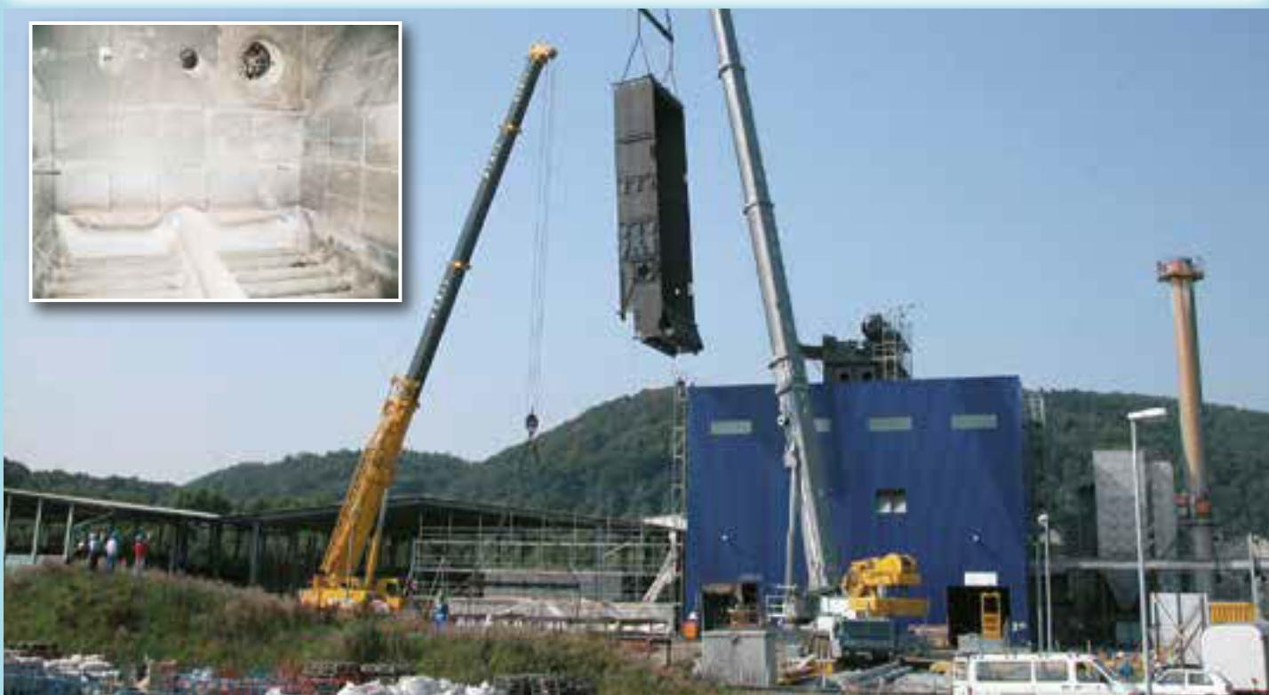
*Generator pare (450° C, 63 bara) • Ložište: ključajući fluidni sloj • Gorivo: otpadno drvo (emisije prema 17. BIMSCHV) Pušteno u pogon: 2003*
