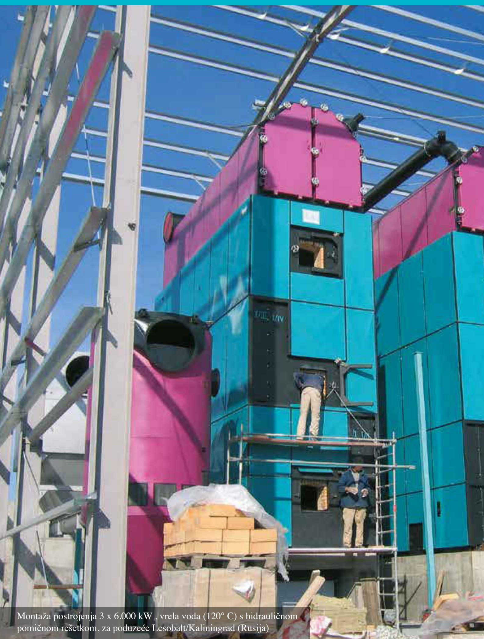
Montaža postrojenja 3 x 6.000 kW , vrela voda ( $120^{\circ}$  C) s hidrauličnom
