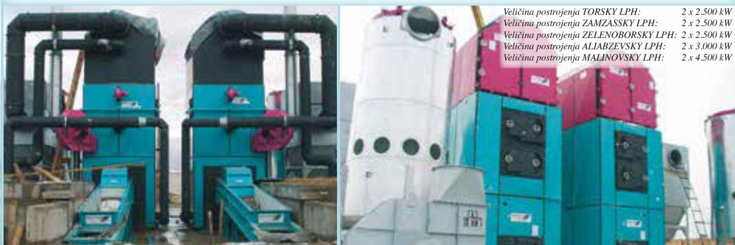
Ložište: hidraulična pomična rešetka • Gorivo: otpadno drvo, kora • Pušteno u pogon: 2003
