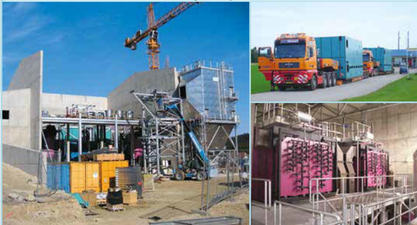
Dimni kotao (23 bar, 420° C) • Ložište: hidraulična pomična rešetka
