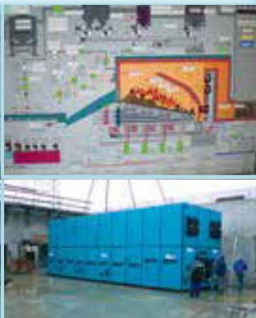
Kotao s termo uljem i ORC modulom, Ložište: hidraulična pomična rešetka
