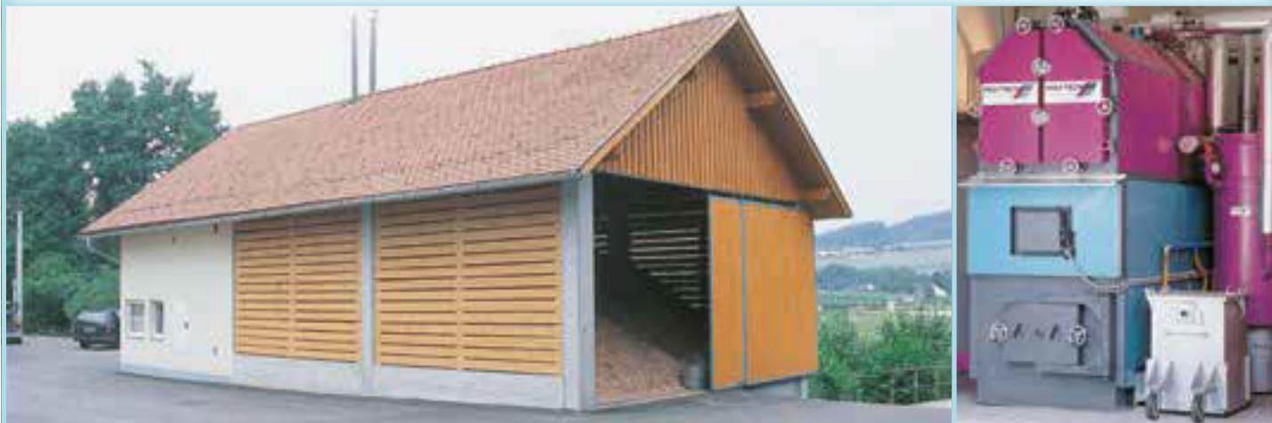
Ložište: podna doprema • Gorivo: šumskidrvni otpad • Pušteno u pogon: 2000
