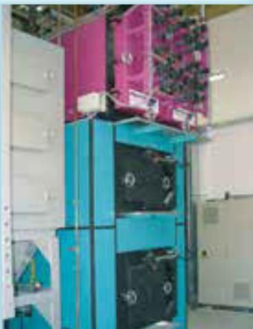
Ložište: hidraulična pomična rešetka • Gorivo: konjski stajnjak sa steljom • Pušteno u pogon: 2003
