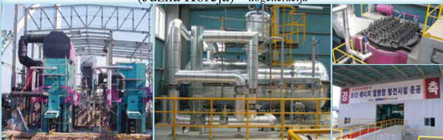
Vruća para pod pritiskom (430° C, 28 bara) i zasićena para (180° C, 8 bara) • Ložište: hidraulična pomična rešetka
