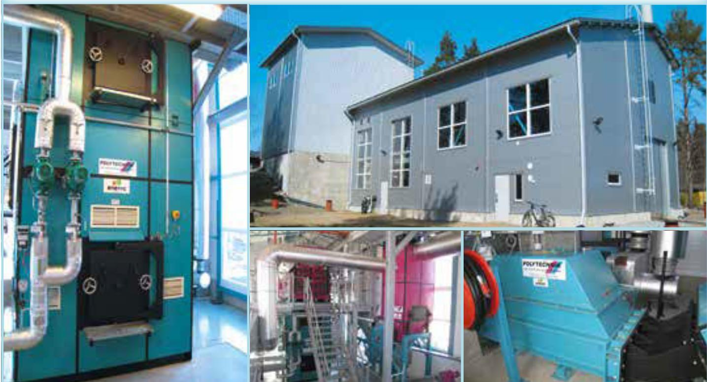
Vruća voda  $120^{\circ} C$ , 10 bara, kogeneracija toplana • Ložište: hidraulična pomicna rešetka
