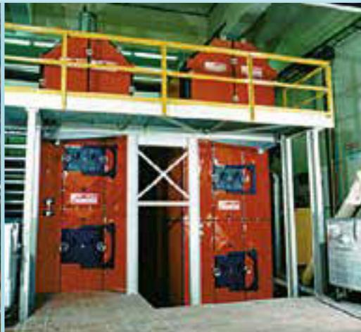
Ložište: hidraulična pomična rešetka • Gorivo: naplavljeno drvo, kora, drvna sječka • Pušteno u pogon: 1990
