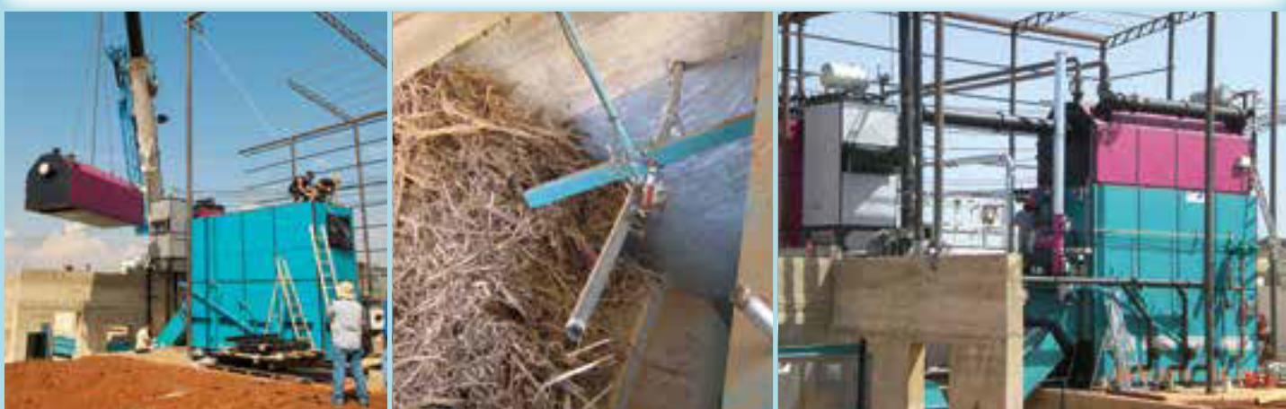
Topla voda (95°C) • Ložište: hidraulična pomična rešetka • Gorivo: kora, korijenje, drvna sječka • Pušteno u pogon: 2010
