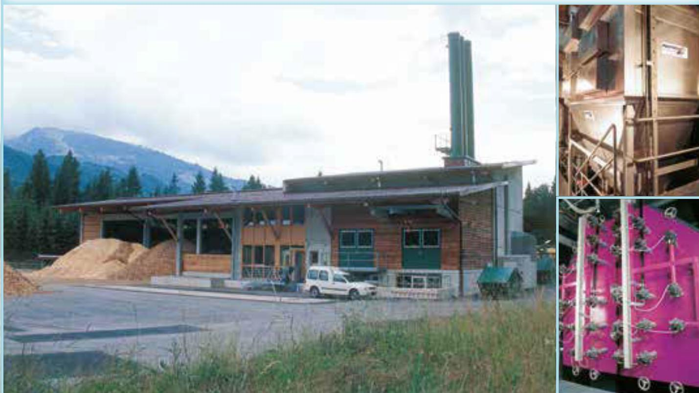
*Ložište: hidraulična pomična rešetka • Gorivo: drvna sječka, kora • Pušteno u pogon: 2000*
