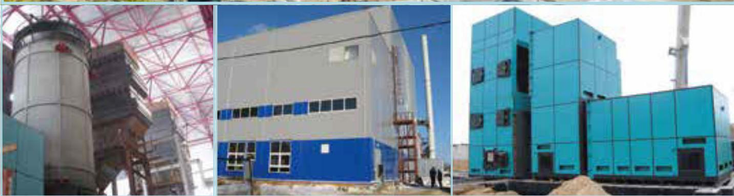
*Kotao s termo uljem s ORC modulom, odvajanje topline za daljinsko grijanje • Ložište: hidraulična pomična rešetka
