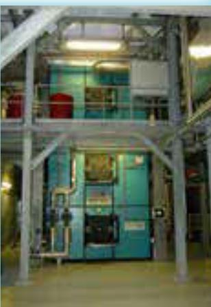
Ložište: hidraulična pomična rešetka • Gorivo: drvna sječka za dobivanje energije, kora, piljevina
