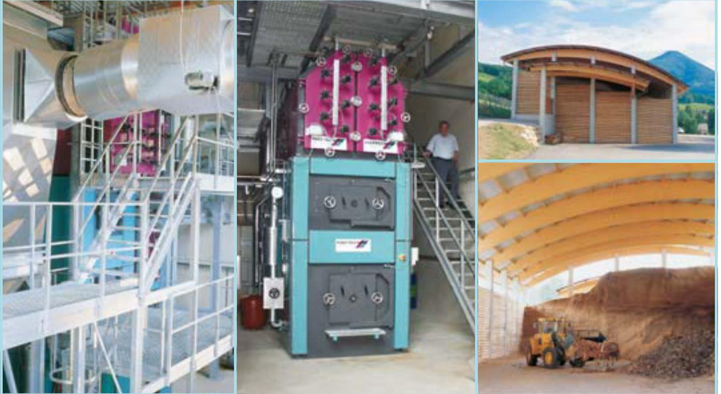
Type fyring: hydraulisk ristfyringssystem • brensel: skogsflis, bark • igangkjørt: 2002
