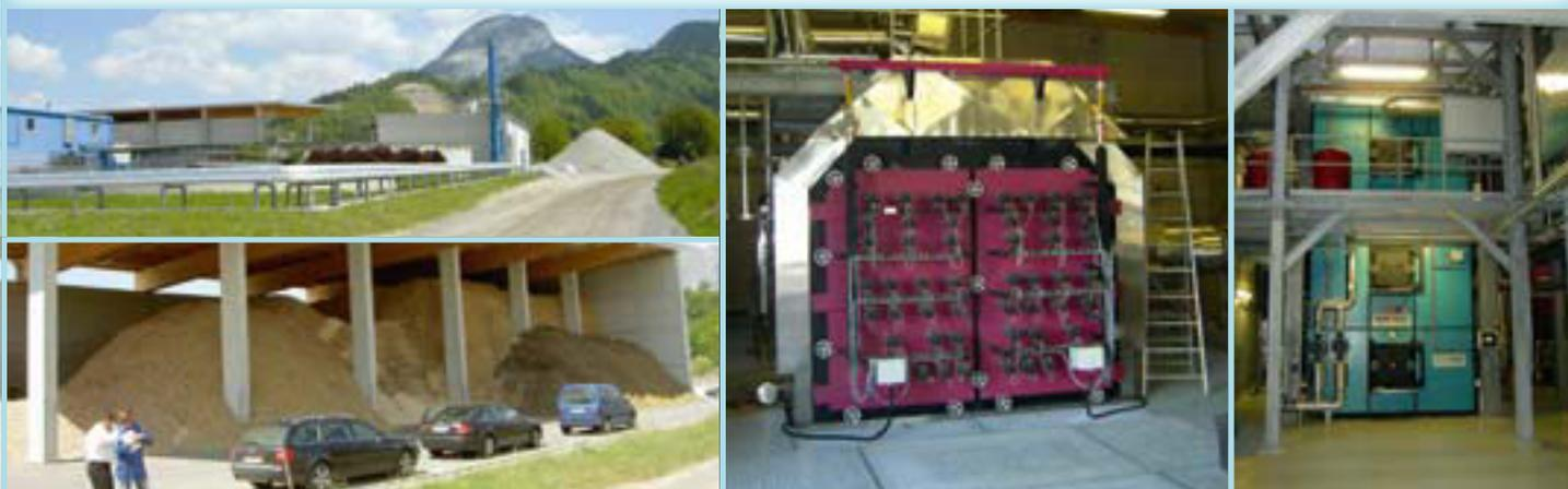
*Type fyring: hydraulisk ristfyringsssystem • brensel: behandlet treflis, bark, sagspan • igangkjørt: 2007*
