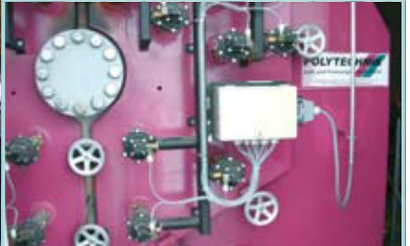
Høytrykk damp 450° C, 32 bar, tilkoblet fjernvarme • type fyring: hydraulisk ristfyringsystem
