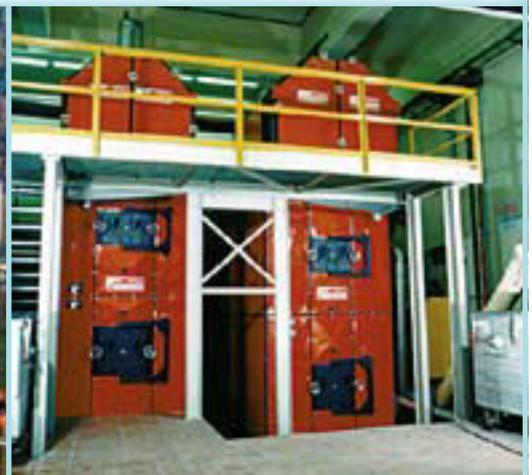
Type fyring: hydraulisk ristfyringsssystem • brensel: driv tømmer, bark, kutterflis • igangkjørt: 1990
