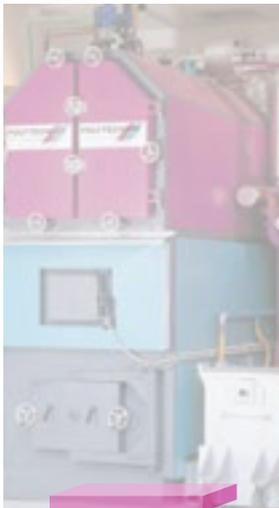
Lokal varme, 230 kW, varmt vann 95° C
