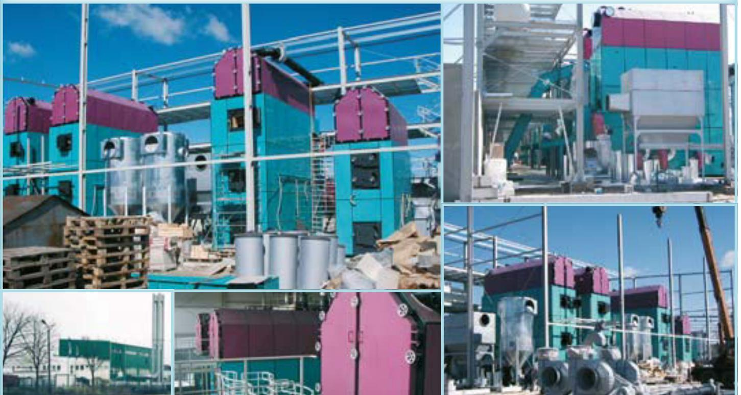
*Anleggsstørrelse: 3 x 6000 kW, 1 x 3000 kW • type fyring: hydraulisk ristfyringsystem • brensel: høvelflis, bark og tre fra sagbruk • igangkjørt: 2003*
