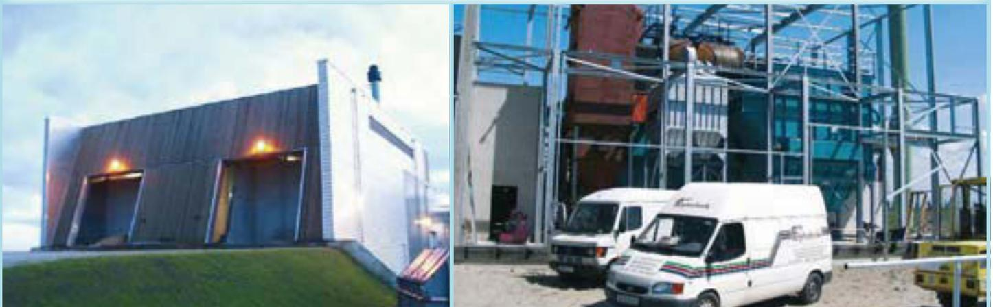
Maks. dampkapasitet: 10,000 kg/h • maks. driftstrykk: 32 bar • type fyring: hydraulisk ristfyringsystem
