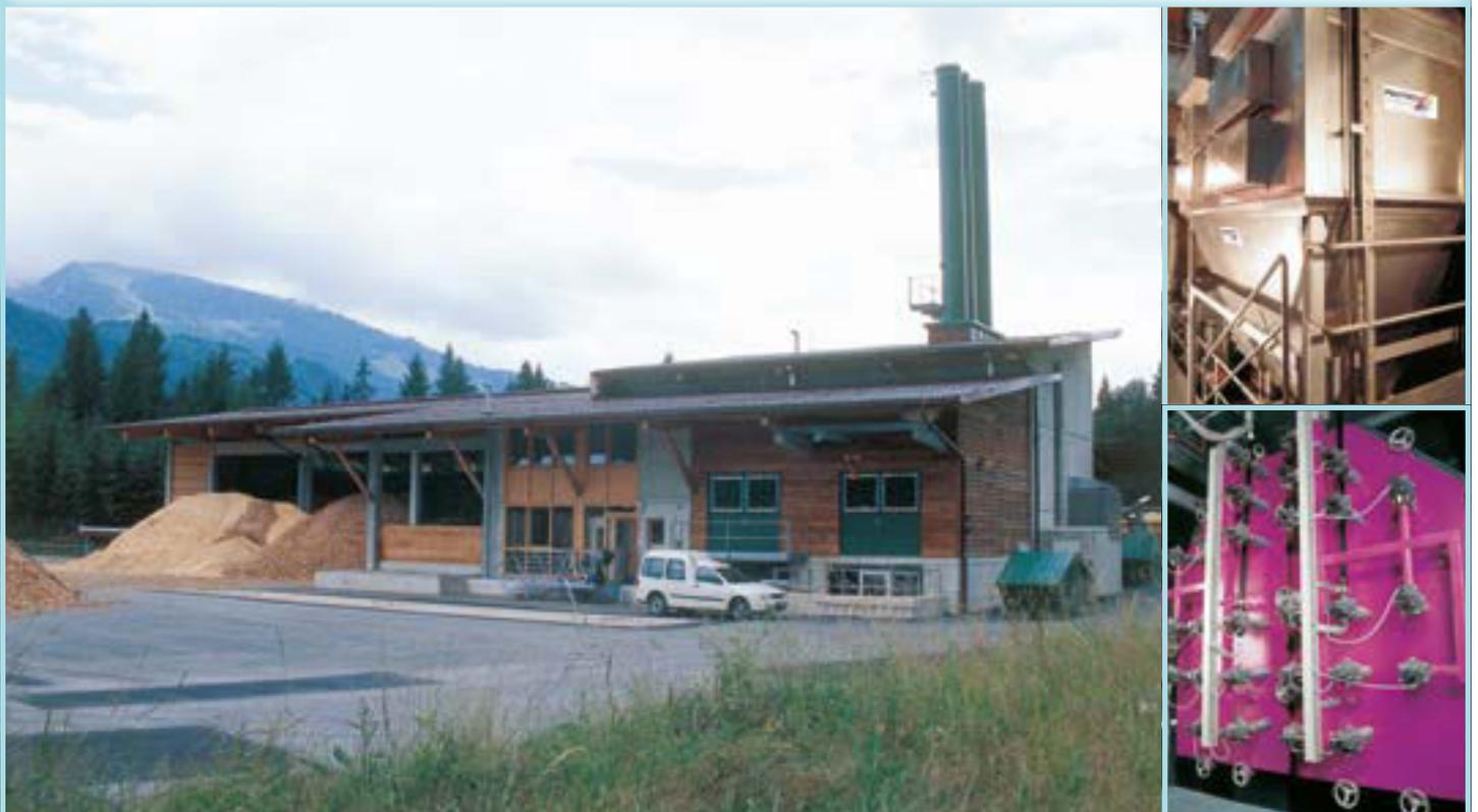
Type fyring: hydraulisk ristfyringssystem • brensel: skogsflis, bark • igangkjørt: 2000
