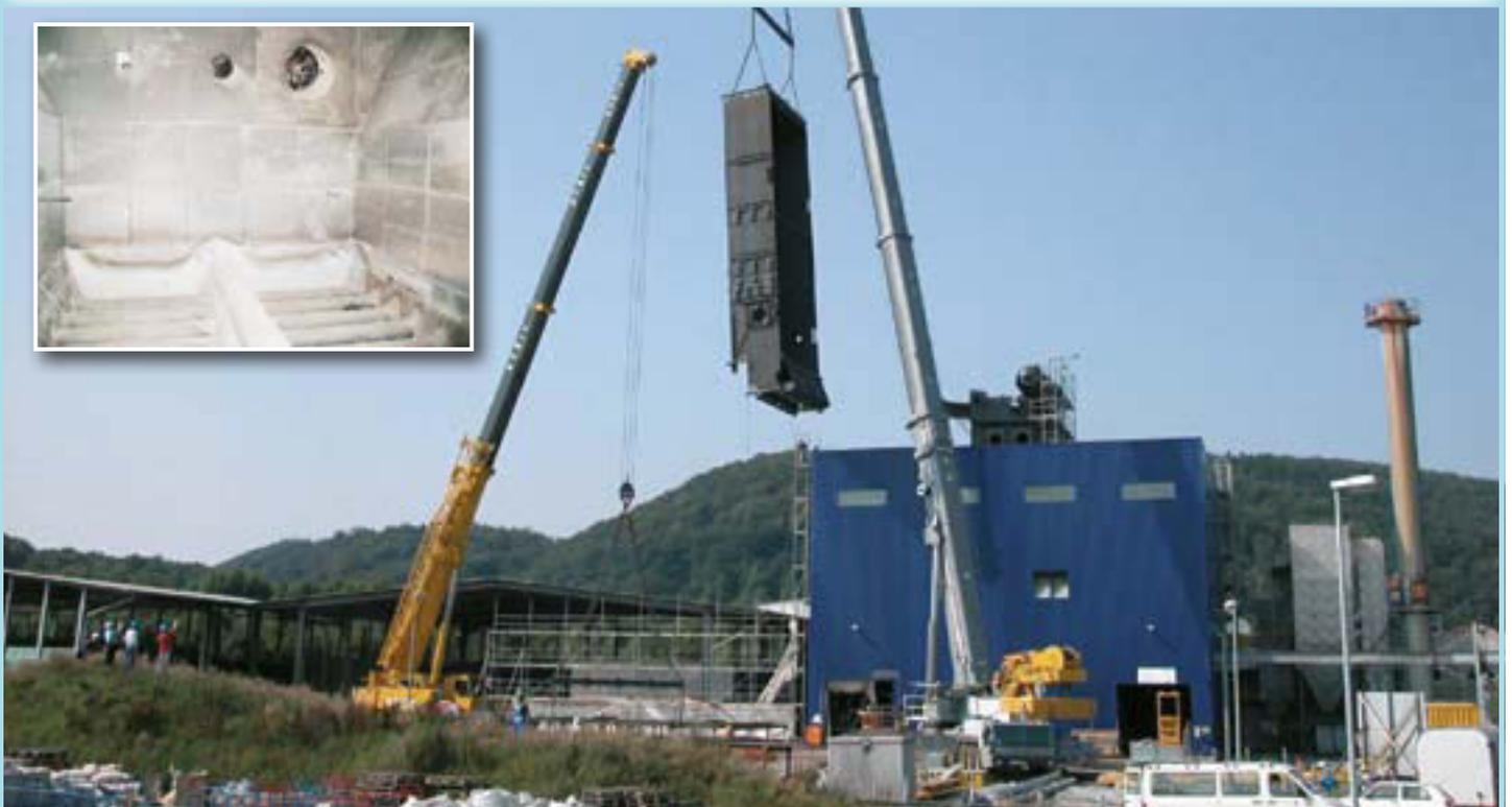
Dampgenerator (450oC, 63 ) • Type fyring: fluidisert sjikt-fyring
