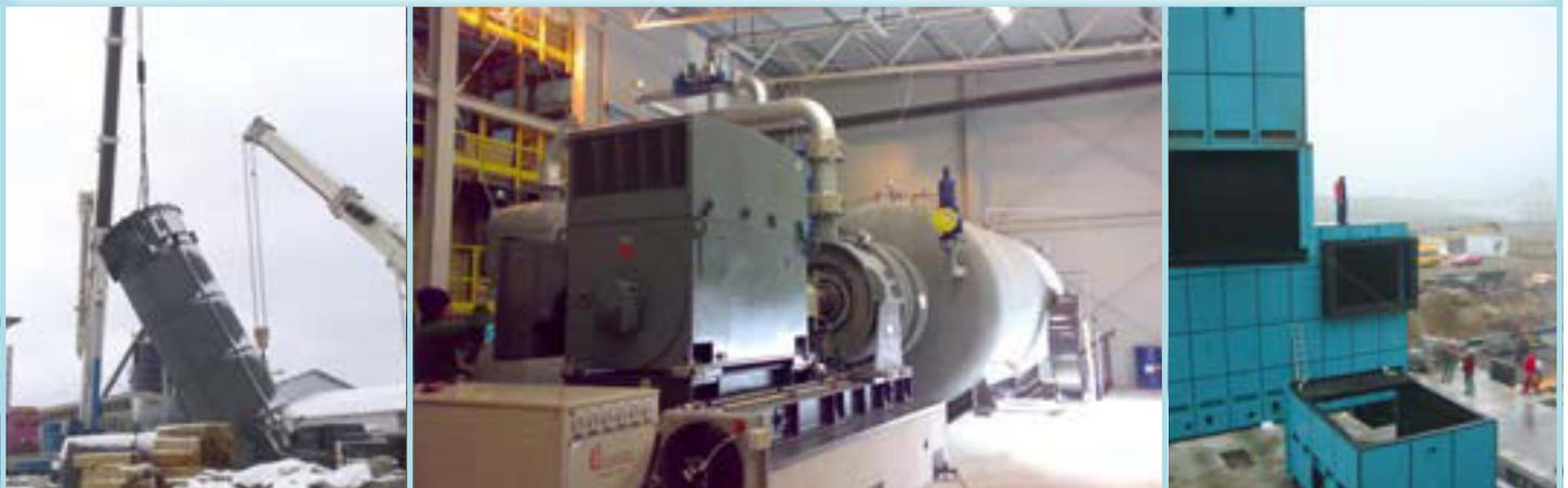
Termo-olje kjelanlegg med ORC enhet • Type fyring: hydraulisk ristfyringsystem
