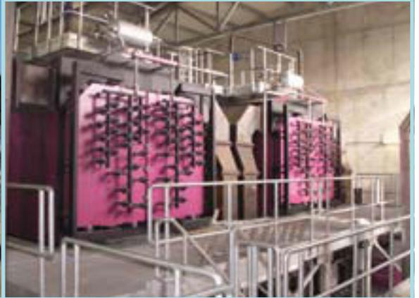
*Røykrørskjel (23 bar, 420° C) • Type fyring: hydraulisk ristfyringsystem
