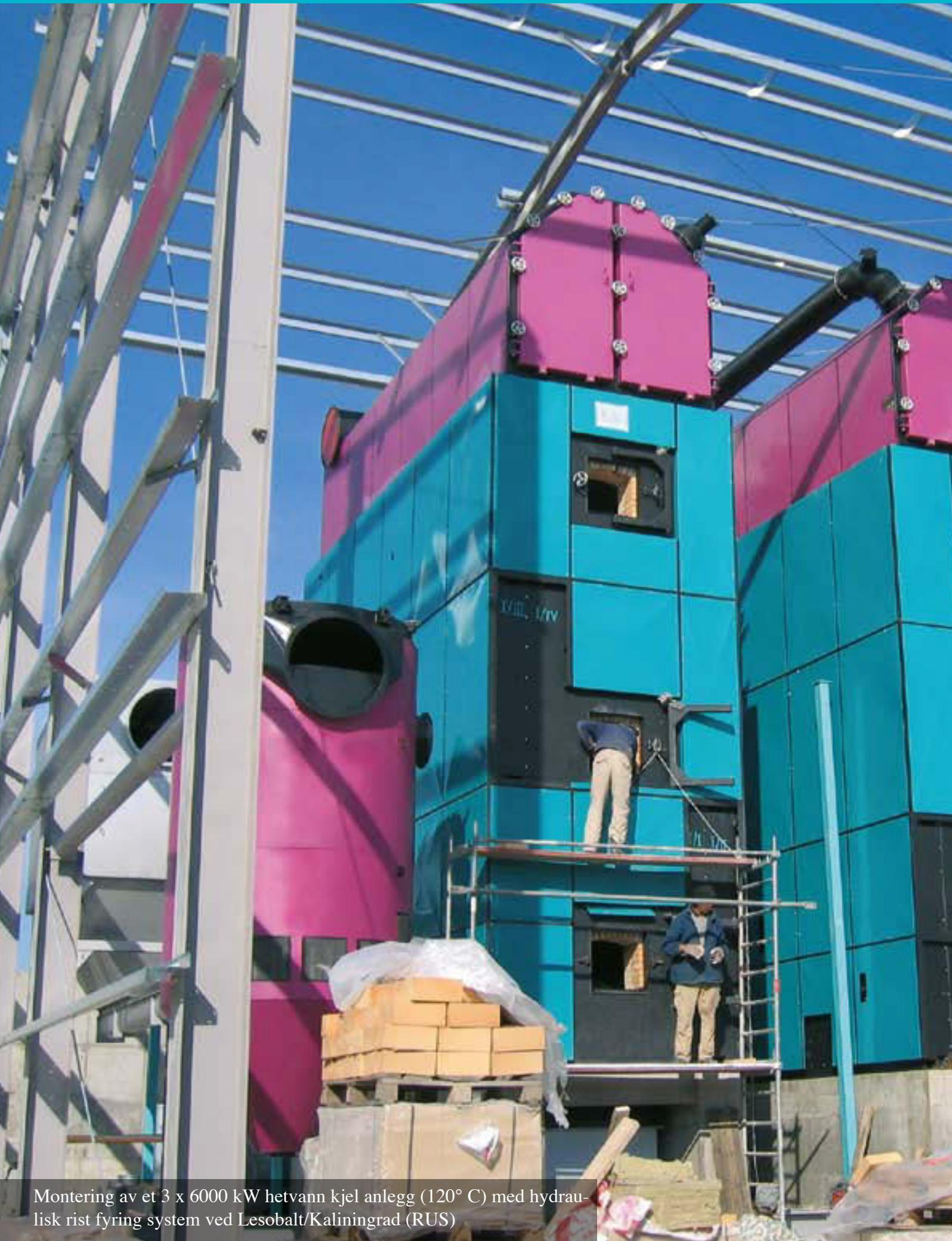
Montering av et 3 x 6000 kW hetvann kjel anlegg (120° C) med hydraulisk rist fyring system ved Lesobalt/Kaliningrad (RUS)
