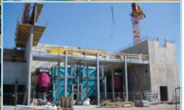
Røykrørskjel (23 bar, 420° C) • Type fyring: hydraulisk ristfyringsystem
