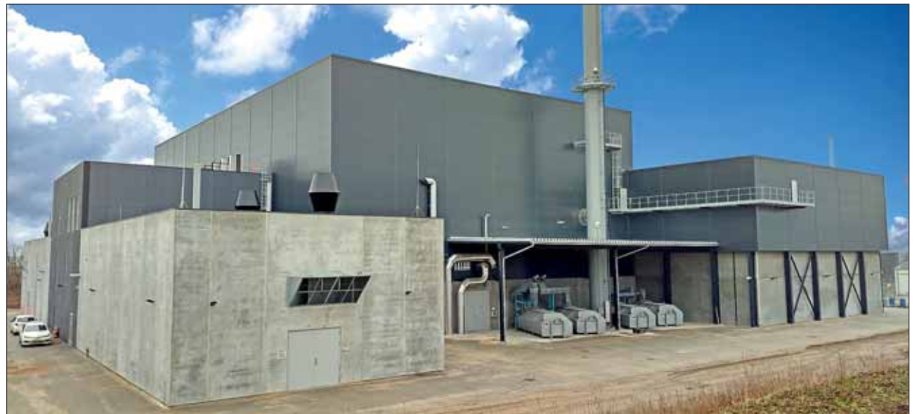
Außenansicht des Biomasse-HKW der Hillerød Forsyning. Eine Besonderheit in dieser Dimension ist der Einsatz von ORC-Anlagen. Für Polytechnik war es das bisher größte Biomasseprojekt mit dieser Technologie. Fotos: Polytechnik
