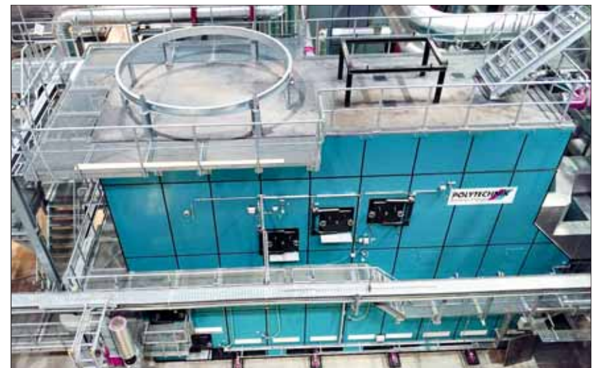
Während der Bauphase: Blick auf die Feuerbox
