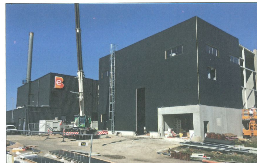
In Eisenstadt wird von Polytechnik ein Biomasseheizwerk errichtet: Außenansicht Heizhaus zum Zeitpunkt der Montage Fotos: Polytechnik
