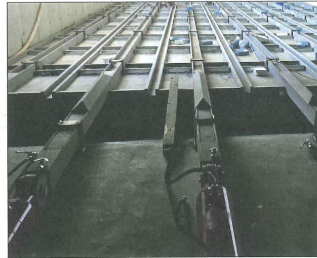
Blick auf die hydraulisch bewegten Schubstangen im Brennstoffbunker
