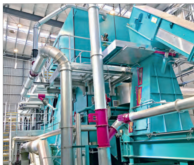
... installierten die Österreicher für Pan-Pac in Milburn eine Heißwasseranlage. Beide werden mit Resten aus der Produktion – überwiegend Rinde – beheizt und dienen der Versorgung der Trockenkammern der Werke. Fotos: Polytechnik Neuseeland
