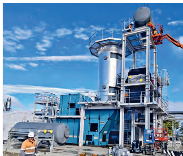
Aktuell baut Polytechnik eine Thermoöl-Anlage für den Konstruktionsholzhersteller WET Gisborne.
