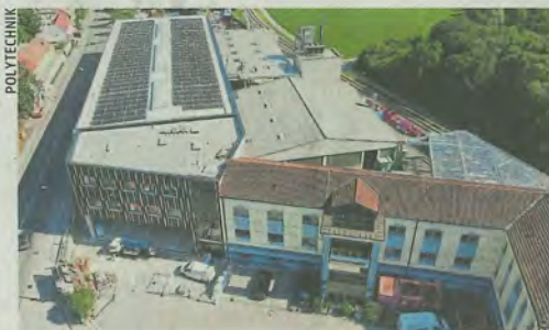
Polytechnik-Zentrale im niederösterreich. Weissenbach an der Triesting
